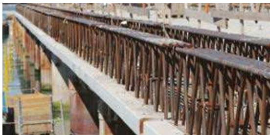
PARTICOLARE TRAVI RETICOLARI MISTE
