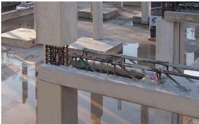
Figure 17. Trave PREM di categoria b) con elementi singoli non piegati.
