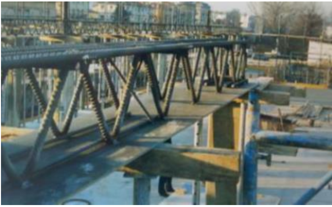
Figure 11. Trave tralicciata mista con acciaio nervato da c.a..
