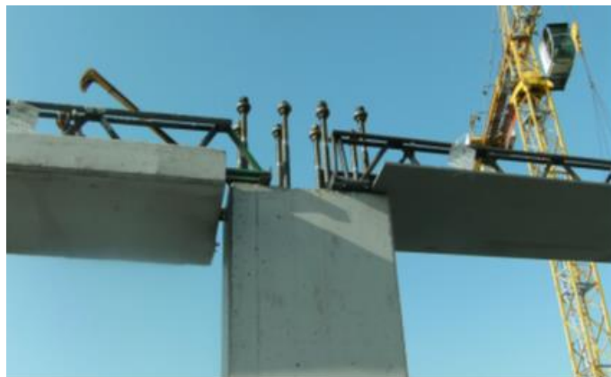
Figure 15. Trave tralicciata mista di categoria a) sia con fondello in acciaio che con fondello in cls.
