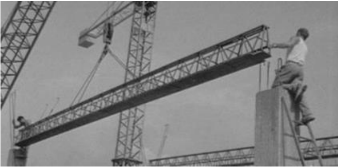
Figure 3. Trave fuori spessore, col marchio REP, brevettata nel 1972.
