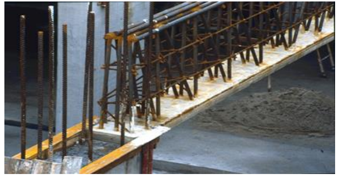
Figure 4. Trave tralicciata mista con fondello di calcestruzzo.
