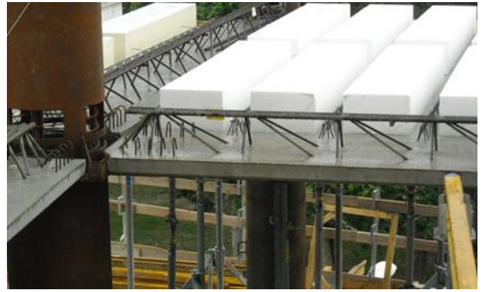
Figure 13. Trave tralicciata mista con anima a puntoni verticali con anima liscia e correnti ad aderenza migliorata.
