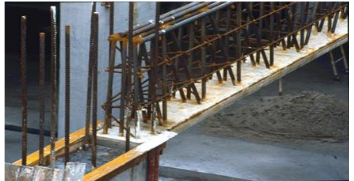
Figure 4. Trave tralicciata mista con fondello di calcestruzzo.
